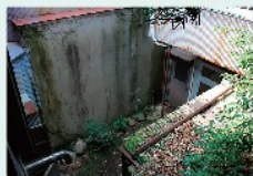
改修前 10年以上空き家だったので、 庭も荒れていた。
